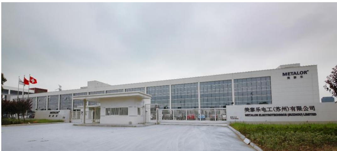
美泰乐苏州（2023 年 4 月起，田中美泰乐电工材料（苏州）有限公司）外观
